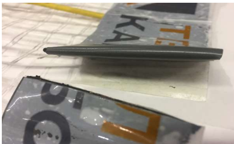
Фото 2. Изоляция места отреза токоведущей шины.
